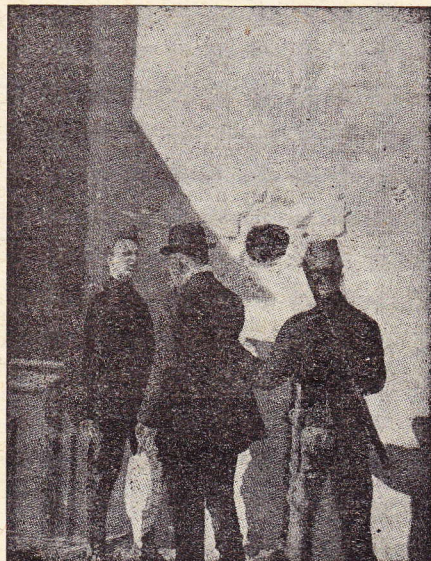
Trace de balle dans le mur de l'église St.-Rombaut à Malines.
