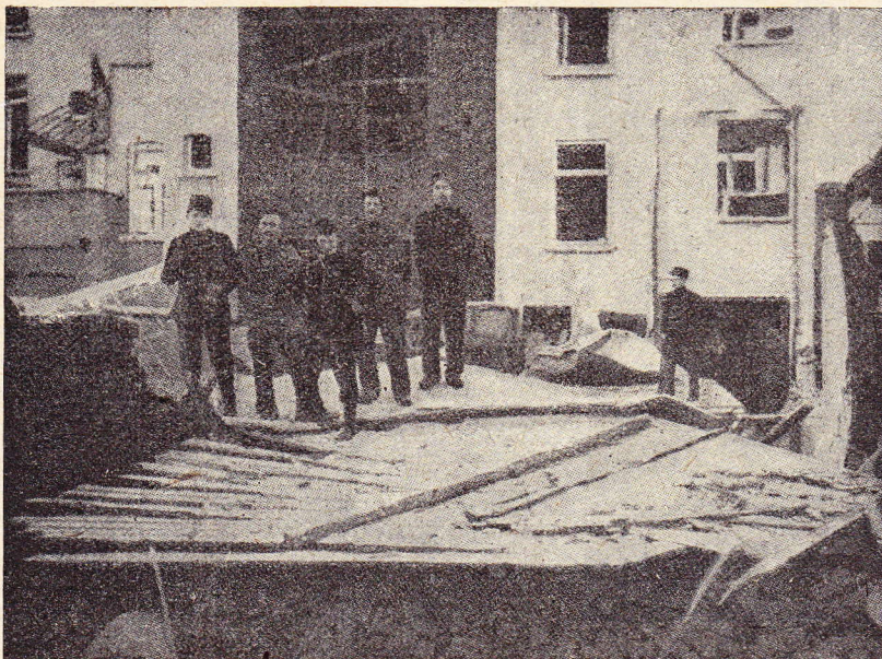
Dégâts causés à Deurne, près d'Anvers, lors de la seconde attaque de Zeppelins, le 2 septembre 1914.
